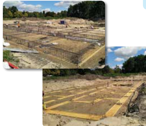
De grondvloeren zijn gelegd.
